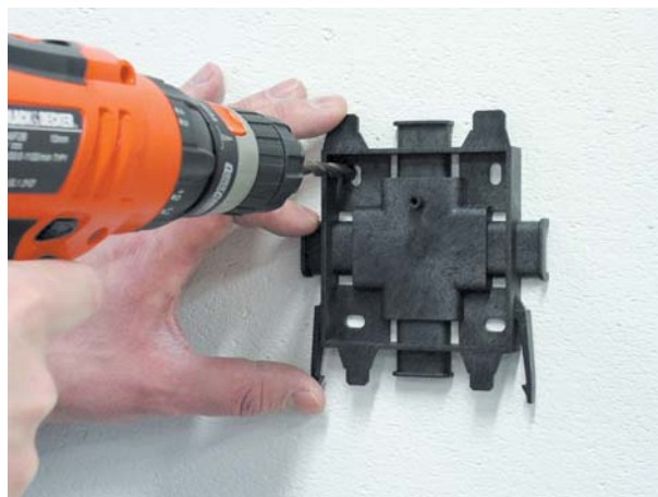
2. Монтирование крепёжного гнезда
